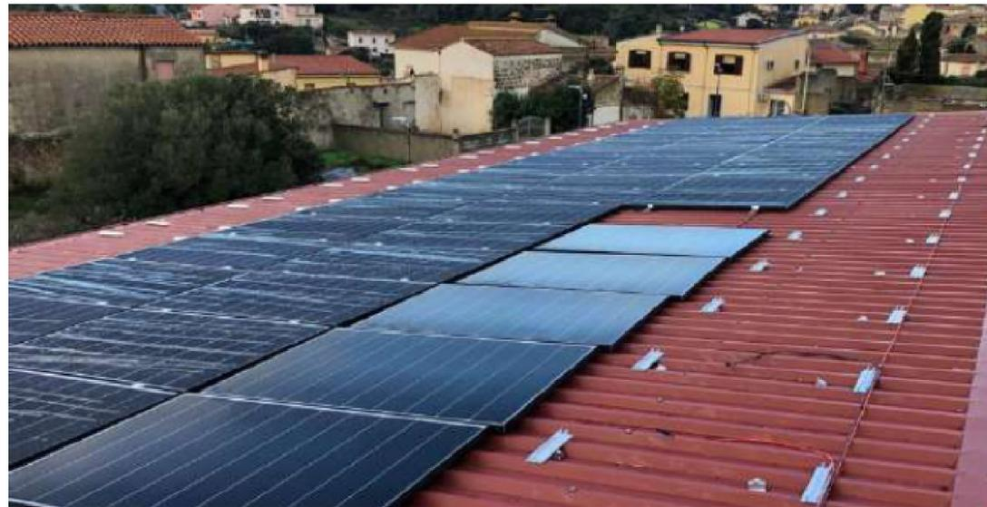
Impianto FV da 60 kW sul tetto della palestra di Villanovaforru; energia prodotta disponibile per la CER di Villanovaforru (costituita il 13 luglio 2021)
