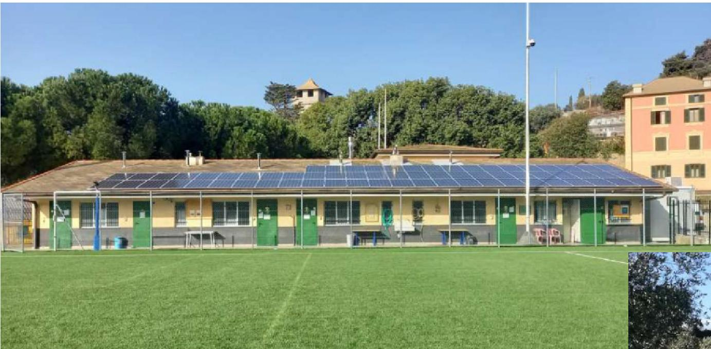
Impianto FV da 11,55 kWp, accumulo da 12,4 kWh e wallbox con pensilina in legno Casole D'Elsa (SI)
